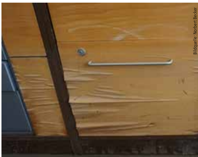
Abb. 4: Aufschüsselungen der Holzkonstruktion aufgrund der Schadwassereinwirkung.
