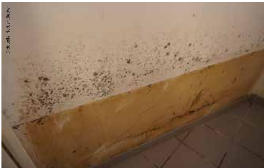
Abb. 2: Nach zwölf Tagen der Durchfeuchtung erheblicher sichtbarer Bewuchs mit Schimmelpilzen, die sich hier kolonieartig blau-grau darstellen.
