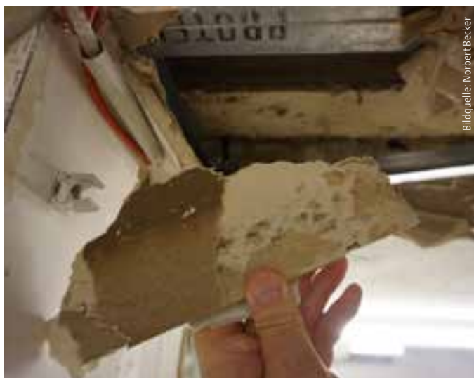
Abb. 3: Alle Gipskartonplatten wiesen im Untergeschoss einen mikrobiellen Bewuchs auf.
