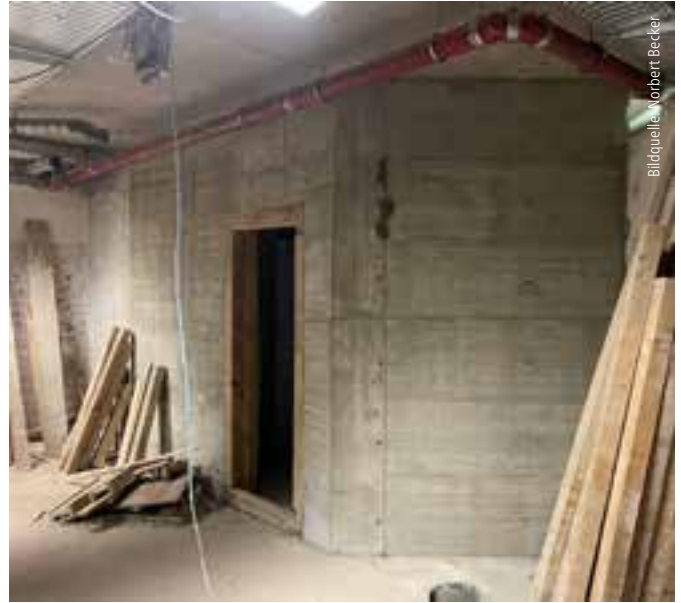
Abb. 8: Abschottung eines schützenswerten Raumes im Untergeschoss durch eine neu errichtete Schleusenwand aus Beton.
