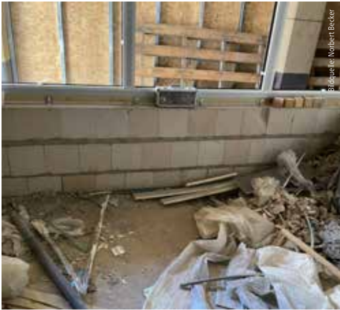
Abb. 9: Erhöhung der Fenster durch eine neuerrichtete Brüstung.
