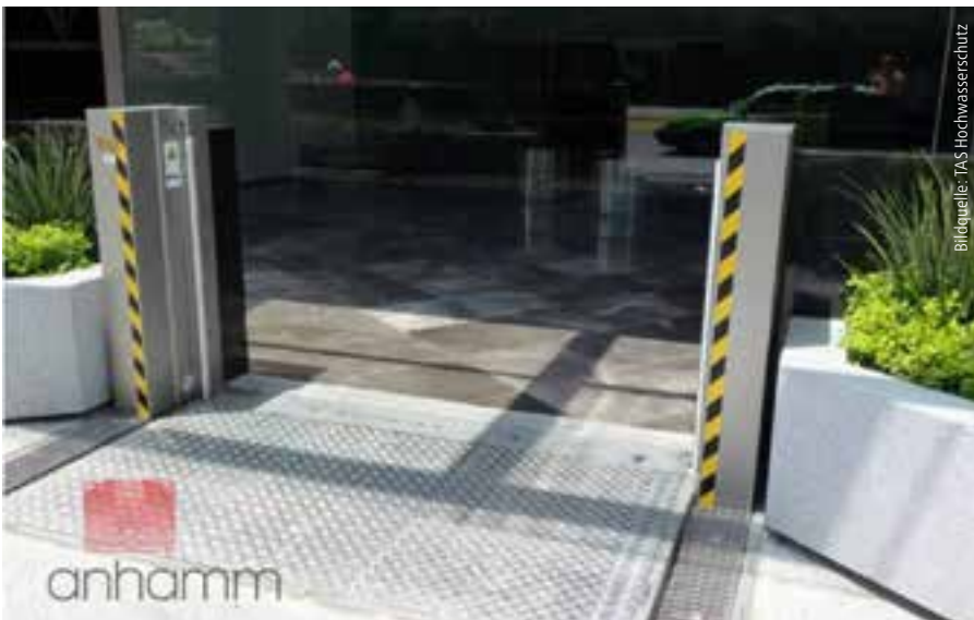
Abb. 11: Beispielhaft dargestellt ist das automatische Sicherheitsklappschott.
