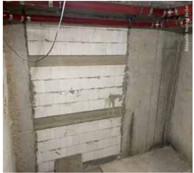
Abb. 10: Der auf Bild 7 dargestellte Lichtschacht wurde verschlossen und außenseitig abgedichtet.
