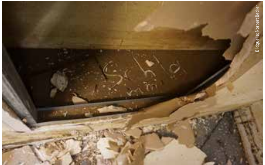
Abb. 5: Zur kontrastreichen Darstellung wurde das Wort „Schlamm“ in den Hohlraum der Trockenbaukonstruktion geschrieben. Das heißt, dass erhebliche Schlammmassen in das Untergeschoss eingeflossen sind.
