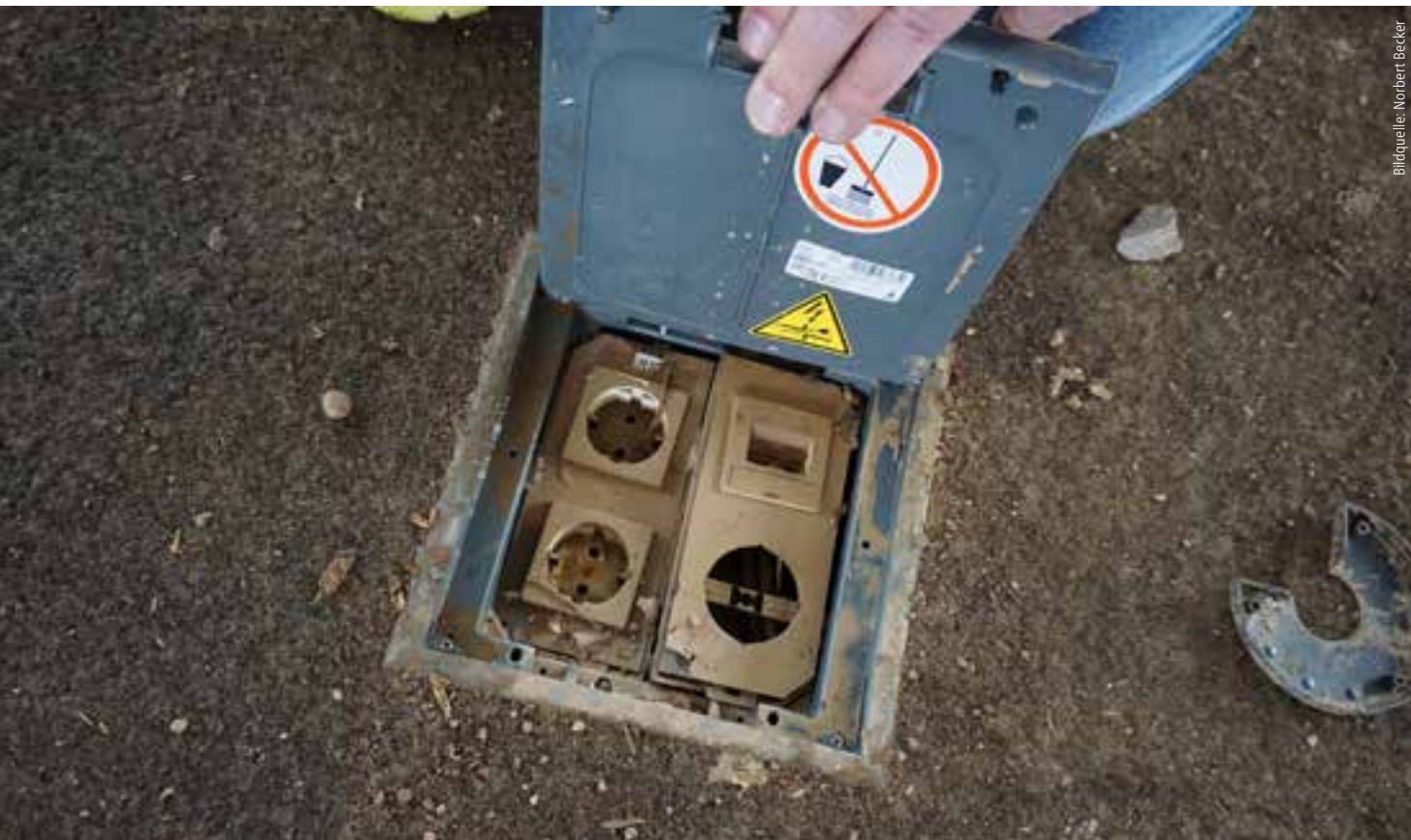
Abb. 1: Verschlammung der Bodenkonstruktion im Erdgeschoss.
