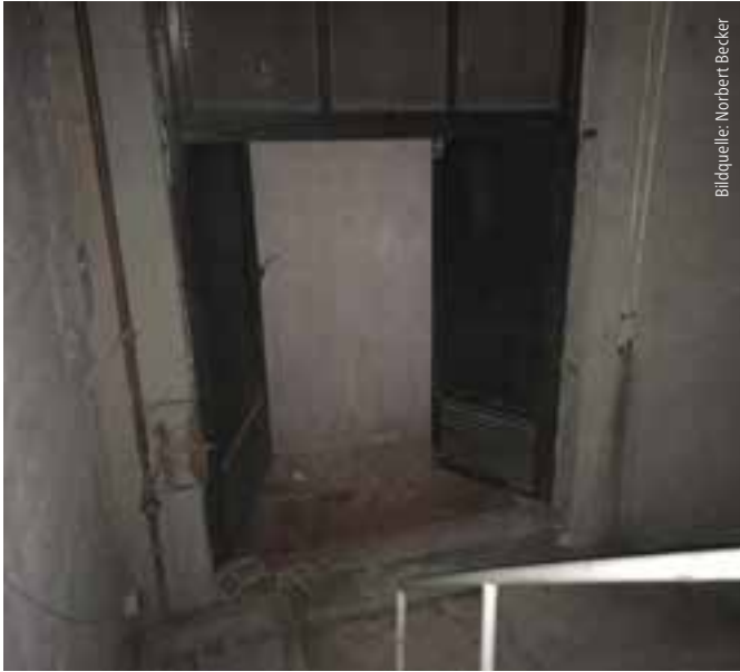
Abb. 7: Straßenfrontseitiger Lichtschacht mit Türe innerhalb des Untergeschosses.
