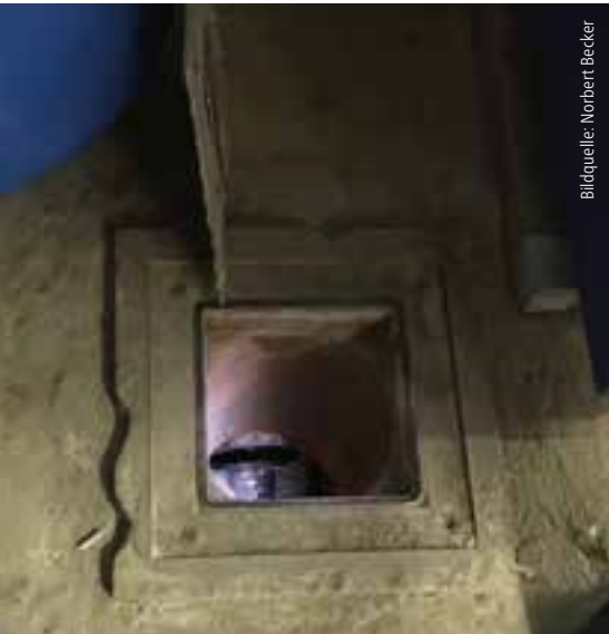
Abb. 6: Die Bodeneinlässe der Flächendrainage sind für einen Hochwasserschutz abzudichten.
