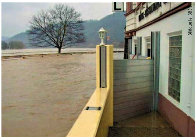
Abb. 7+8: Umlaufender Hochwasserschutz mit teilmobilen Schutzelementen (links) sowie Errichtung eines Sandsackwalls (rechts) [19]
