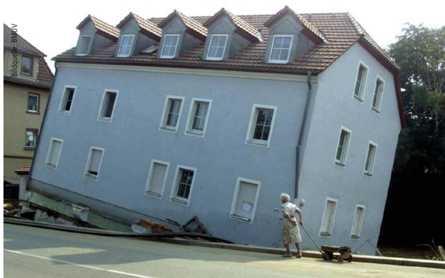
Abb. 3+4: Unterspülung eines Hauses (oben) [17] sowie starke Verschlammung und Schimmelbelastung eines Untergeschosses (links) nach dem Hochwasserereignis 2021 (Becker).
