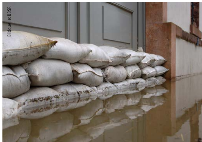
Abb. 7+8: Umlaufender Hochwasserschutz mit teilmobilen Schutzelementen (links) sowie Errichtung eines Sandsackwalls (rechts) [19]
