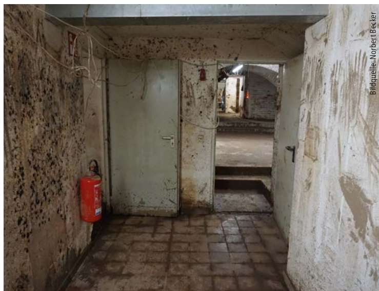
Abb. 3+4: Unterspülung eines Hauses (oben) [17] sowie starke Verschlammung und Schimmelbelastung eines Untergeschosses (links) nach dem Hochwasserereignis 2021 (Becker).
